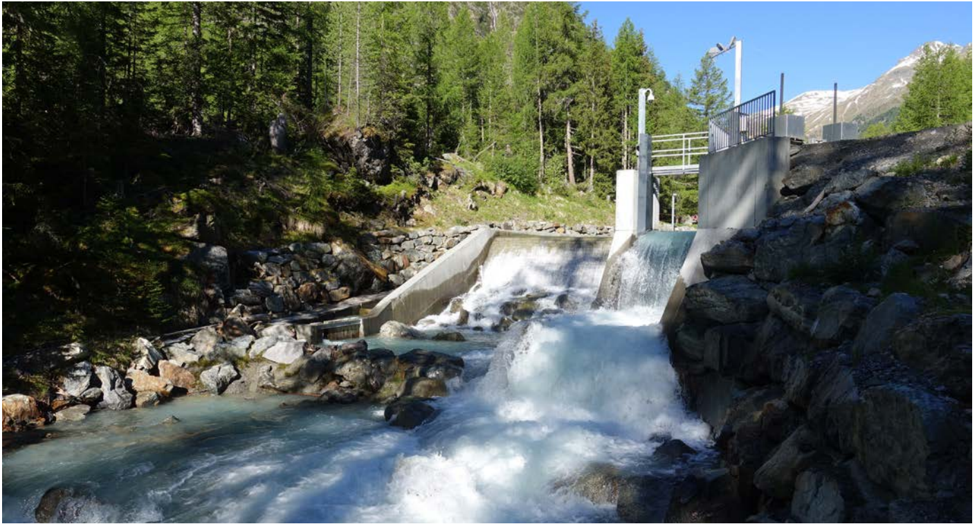
Abb. 2.21: Kleinwasserkraftwerk Susasca mit Fischtreppe
