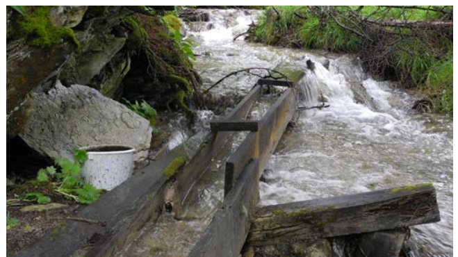
Abb. 3.2: Bach-Wasserfassung für die Bewässerung landwirtschaftlich genutzter Wiesen.
